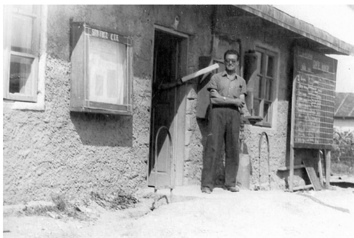
În fața biroului de șantier — Govora, 1958
